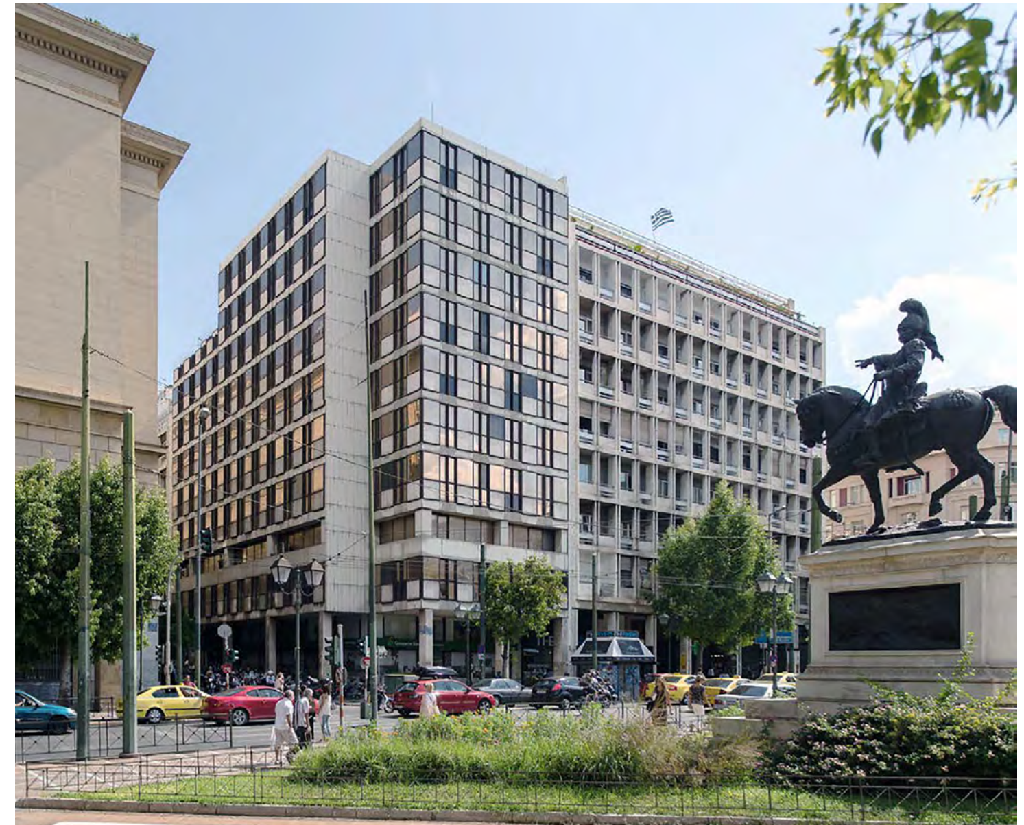
Το κτίριο πριν τις εργασίες αναβάθμισης.
